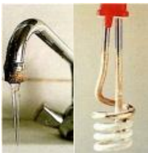
Fig. 17.- Depósitos de cal sobre un grifo y en un elemento calefactor debidos al uso de agua dura
